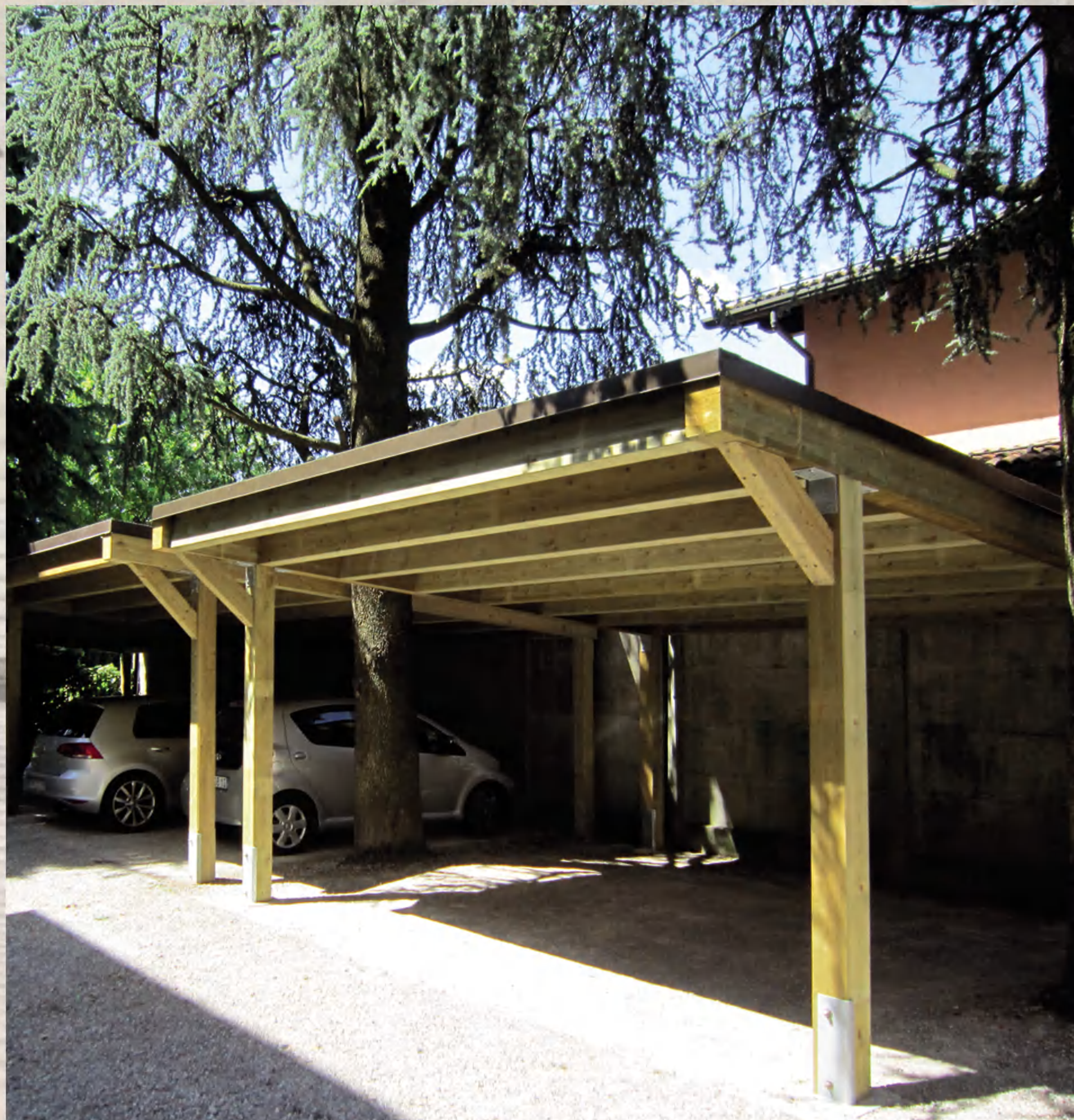
Struttura per copertura auto realizzata a disegno in legno lamellare con copertura in perline e guaina ardesiata
